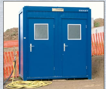
Conteneur WC sur un chantier
