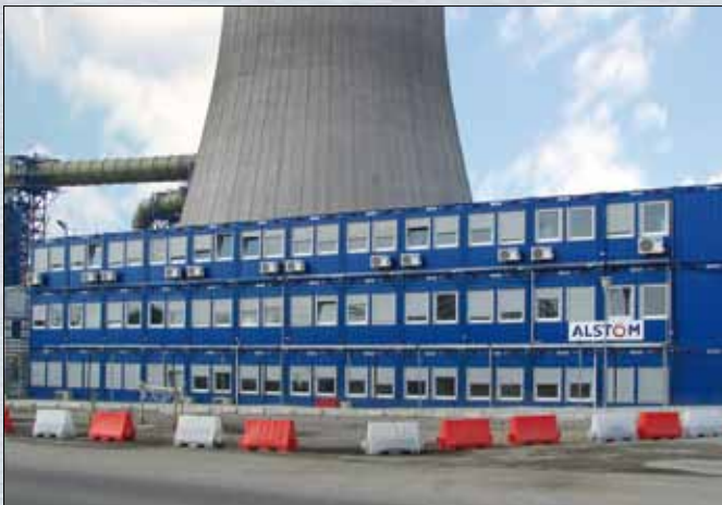
Bureaux de chantier
