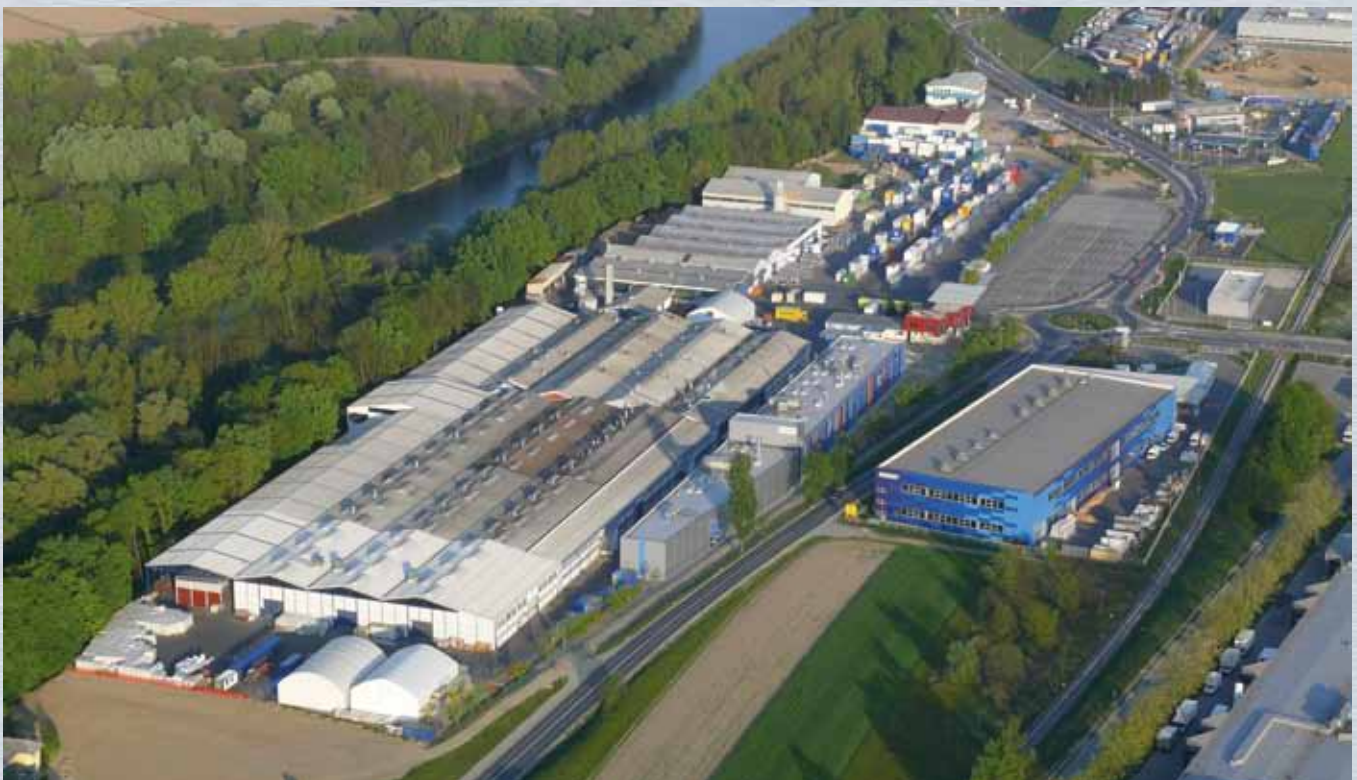
Production de bungalows bureaux et sanitaires dans l'usine de Gornja Radgona (Slovénie)
